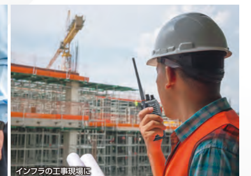
インフラの工事現場に
